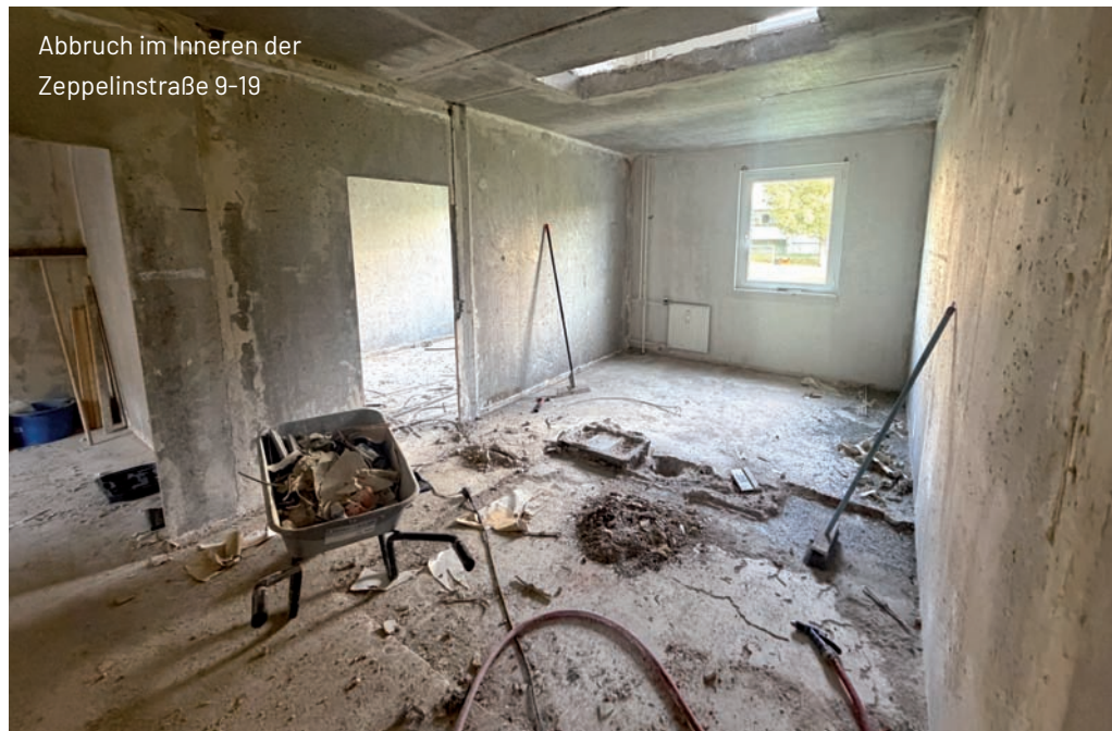
Abbruch der alten Balkone in der Zeppelinstraße 9-19
