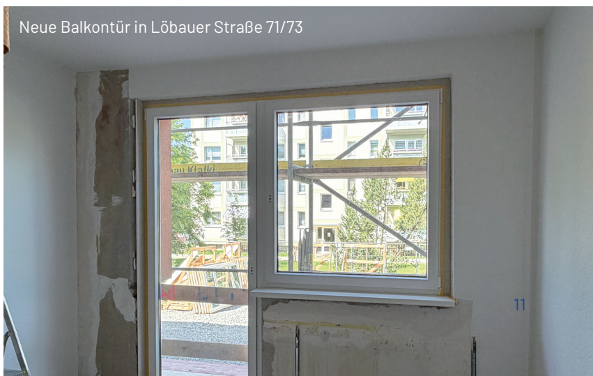
Vorbereitungen für den Balkonanbau Löbauer Straße 71/73
