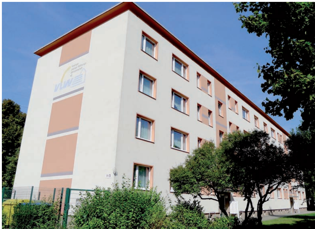
Die Ruhe vor dem Balkonanbau in der Löbauer Straße.
