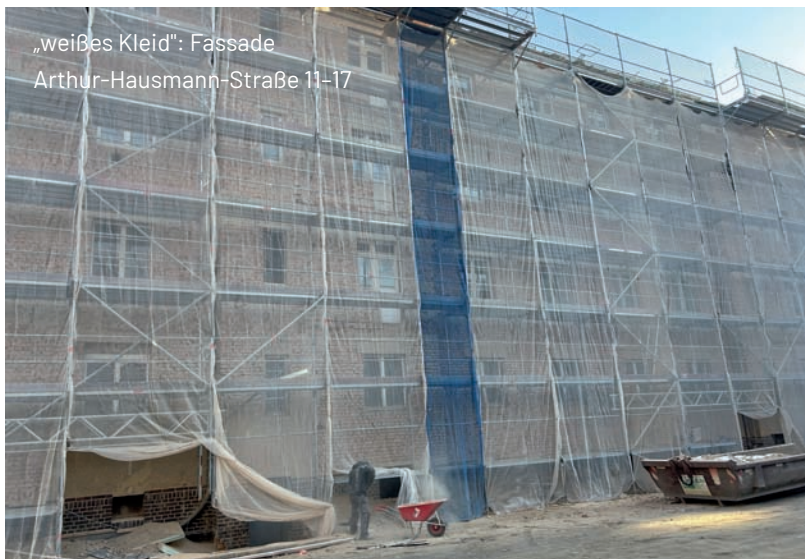
jede Menge neues Baumaterial für die Arthur-Hausmann-Straße 11-17
