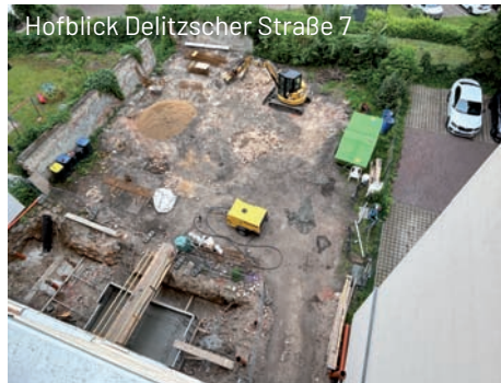
Gründungsarbeiten für neue Balkone in der Delitzscher Straße 7
